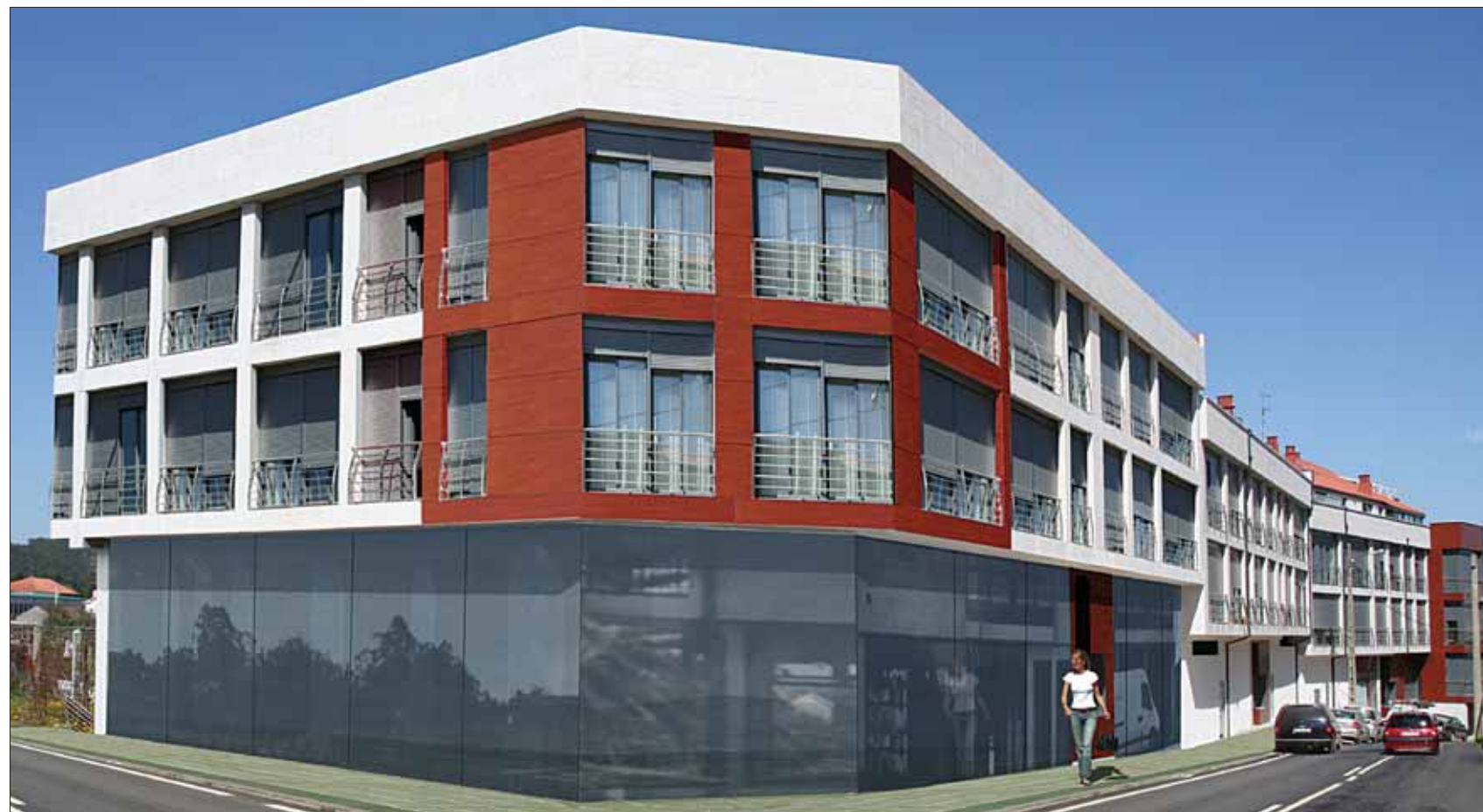
Edificio de nueve viviendas en construcción en Mosteiro, Meis (Pontevedra).
