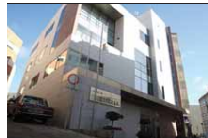
Edificio del concello de Sanxenxo (Pontevedra). / ALBERTO UZAL
