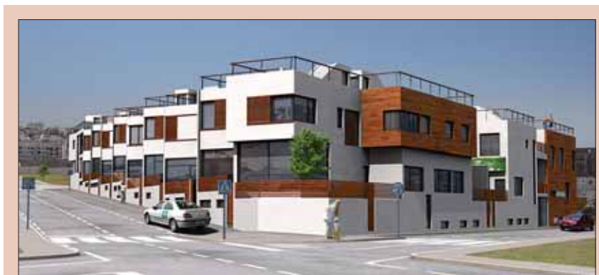
Edificio de 27 viviendas en Puerto del Rosario, Fuerteventura (Islas Canarias).
